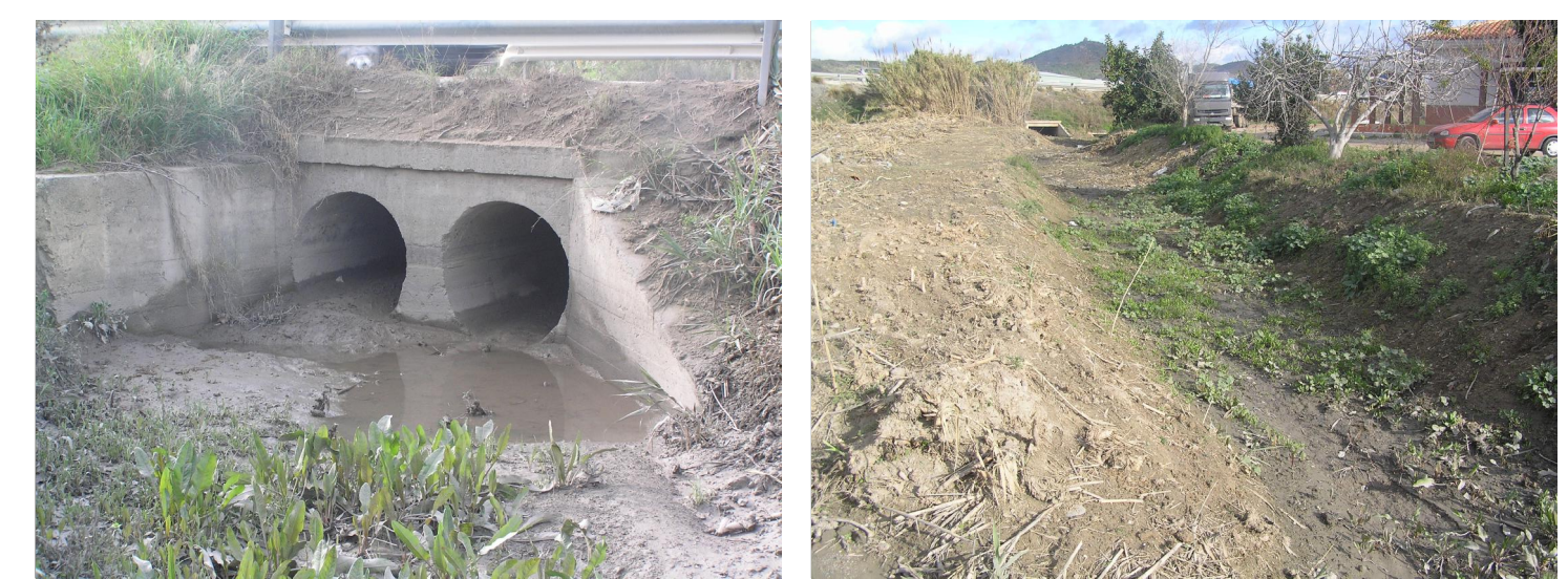
F1 Sección obra de drenaje transversal aguas arriba
