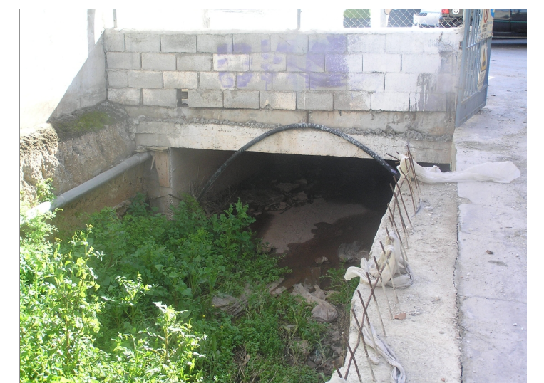
F4 Obra de drenaje transversal aguas arriba
