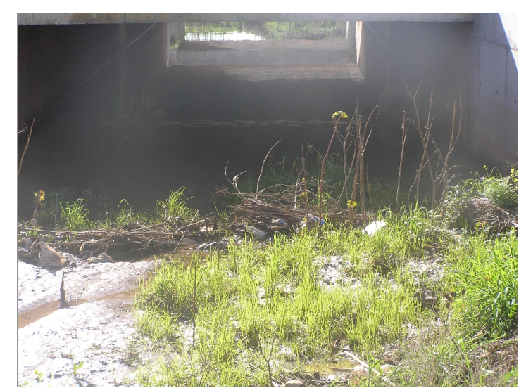
F2 Sección cauce obra de drenaje transversal aguas arriba
