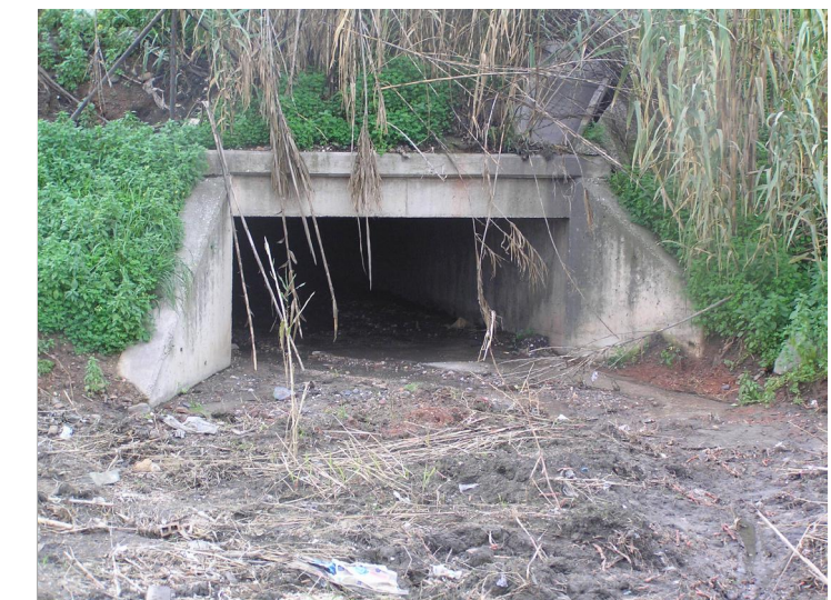
F3 Sección obra de drenaje transversal aguas arriba
