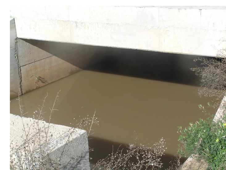
F3 Sección cauce obra de drenaje transversal aguas abajo
