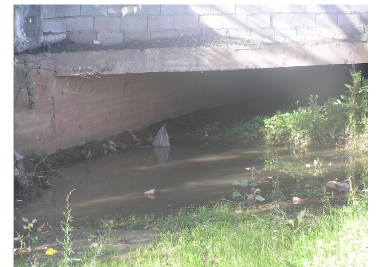
F2 Obra de drenaje transversal aguas abajo
