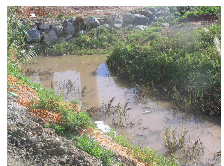
F4 Sección cauce aguas abajo
